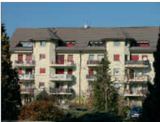
BEX, 47 A-B-C-D, AVENUE DE LA GARE
