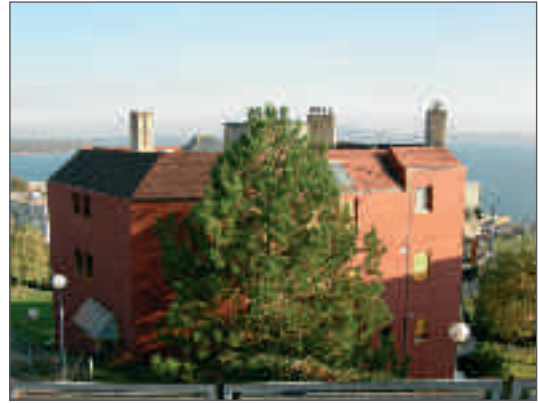
NEUCHÂTEL, 24-28, RUE DES BERTHOUCES
