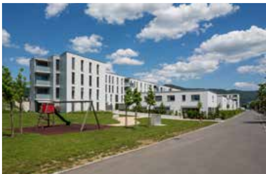
Delémont , 2, rue du Voirnet - 3/9/15/17, rue Emile-Boéchat
