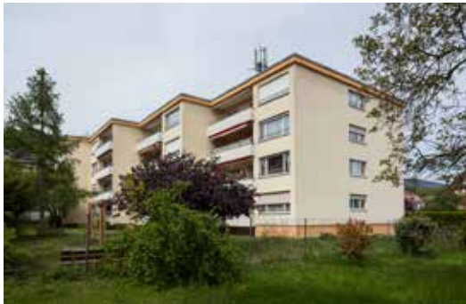
Peseux , 10/12, rue de la Gare
